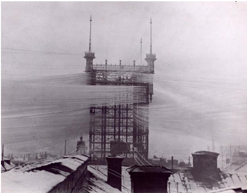
Ett telefontorn på Brunkebergstorg i Stockholm c:a 1890. Från tornet gick det ut över 4000 telefontrådar, enligt en del så tätt att de skymde solljuset. 1939 hade det förlorat sin betydelse som telefontorn då telefonkablarna grävts ner under marken och istället monterades en nybyggd roterande klocka på tornet. Tornet revs 1953 efter en brand medan klockan överlevde och fick flytta till NK-husets tak och därefter fick namnet NK-klockan. Foto: Tekniska museet
